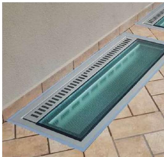
Il lucernario risulta a filo pavimento, il sigillante perimetrale è visibile. Inadeguato per casi di Telaio non a forma di "L".
